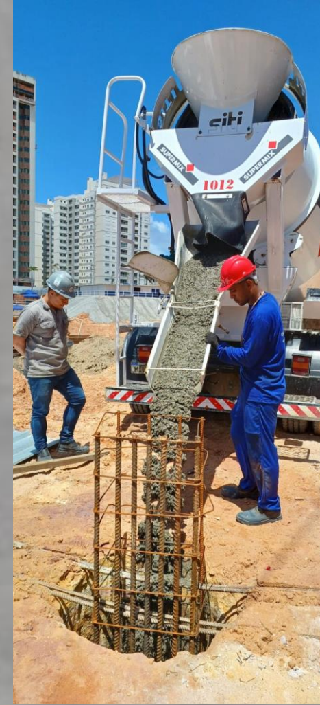
CONCRETAGEM ESTACA DO TRECHO 8
