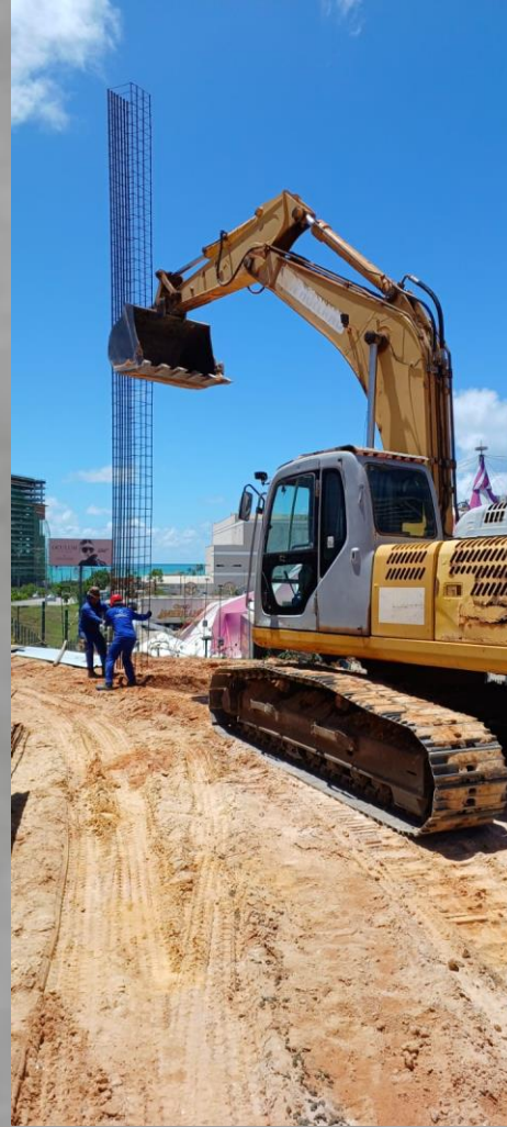
COLOCAÇÃO DE ESTACA DO TRECHO 8
